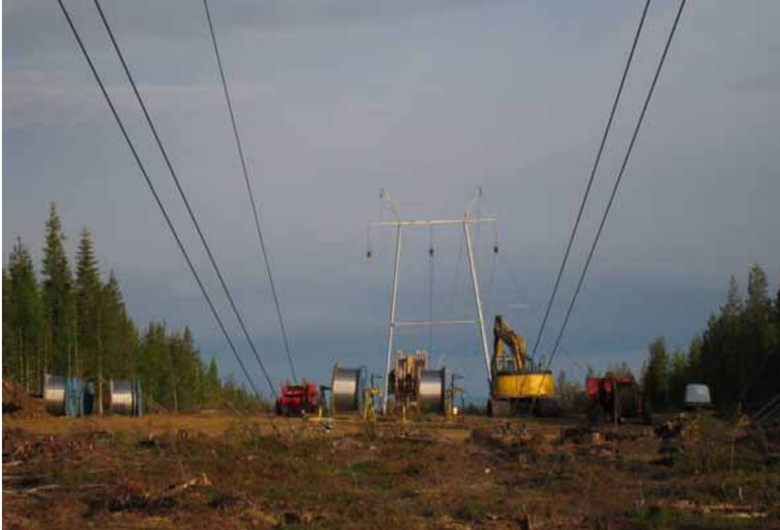
Kuva 9-5. Uuden voimajohdon rakennustyömaa.
