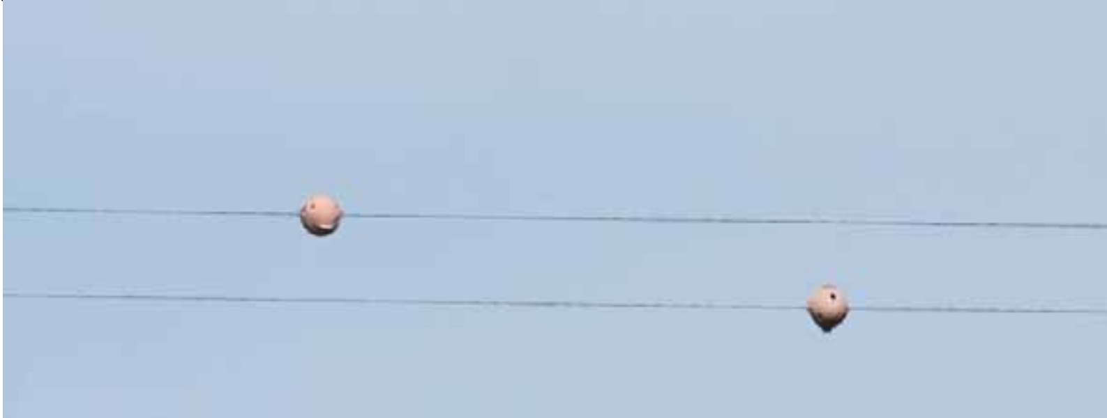
Kuva 12-32. Sähkönsiirron voimajohtoihin asennettavat pallot lisäävät johdinten näkyvyyttä ja vähentävät osaltaan lintujen törmäysriskiä (kuva Ville Suorsa).
