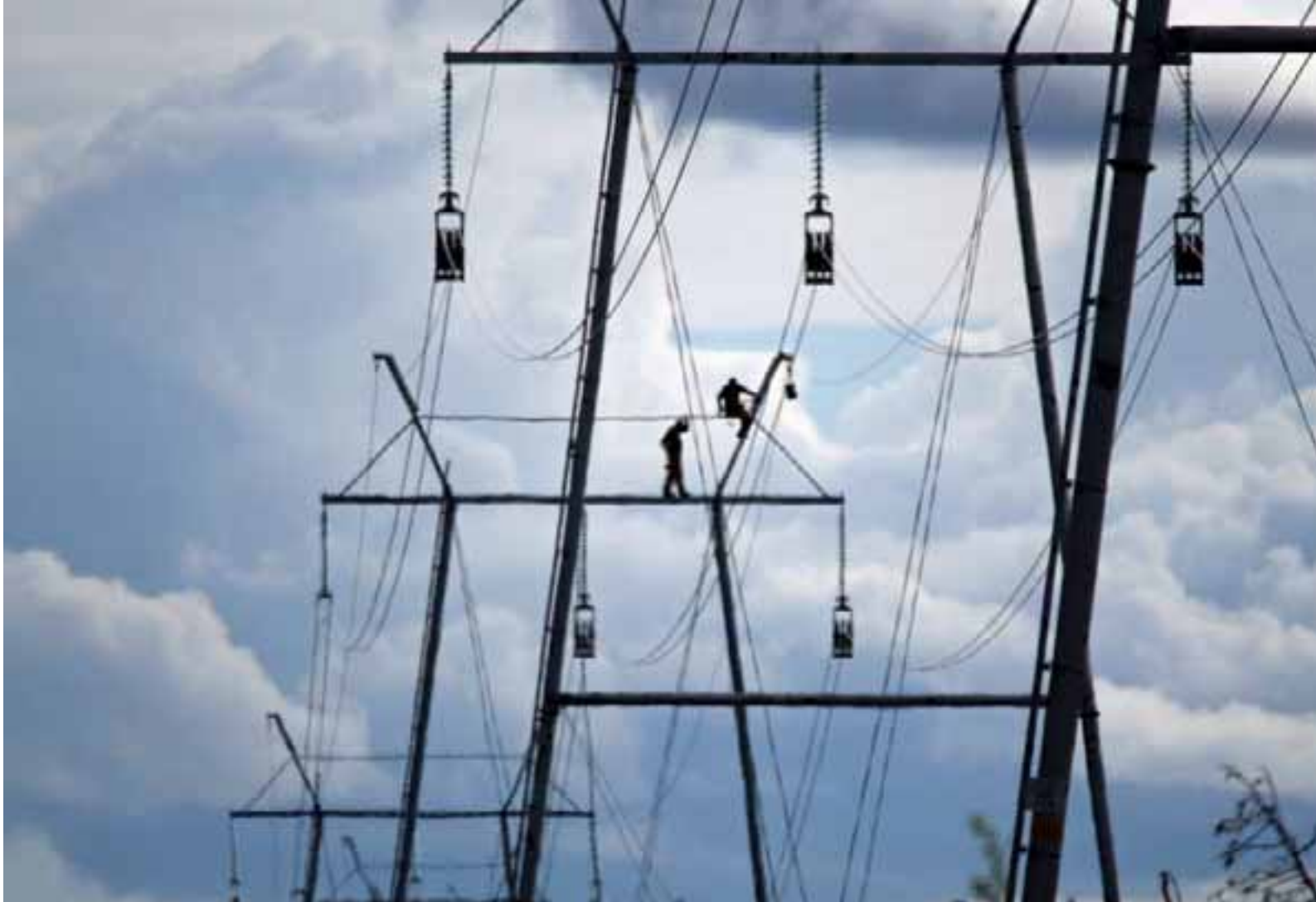
Kuva 6-5. Fingridin 220 kV voimajohdon rakentamista Sodankylän Kautoselässä.
