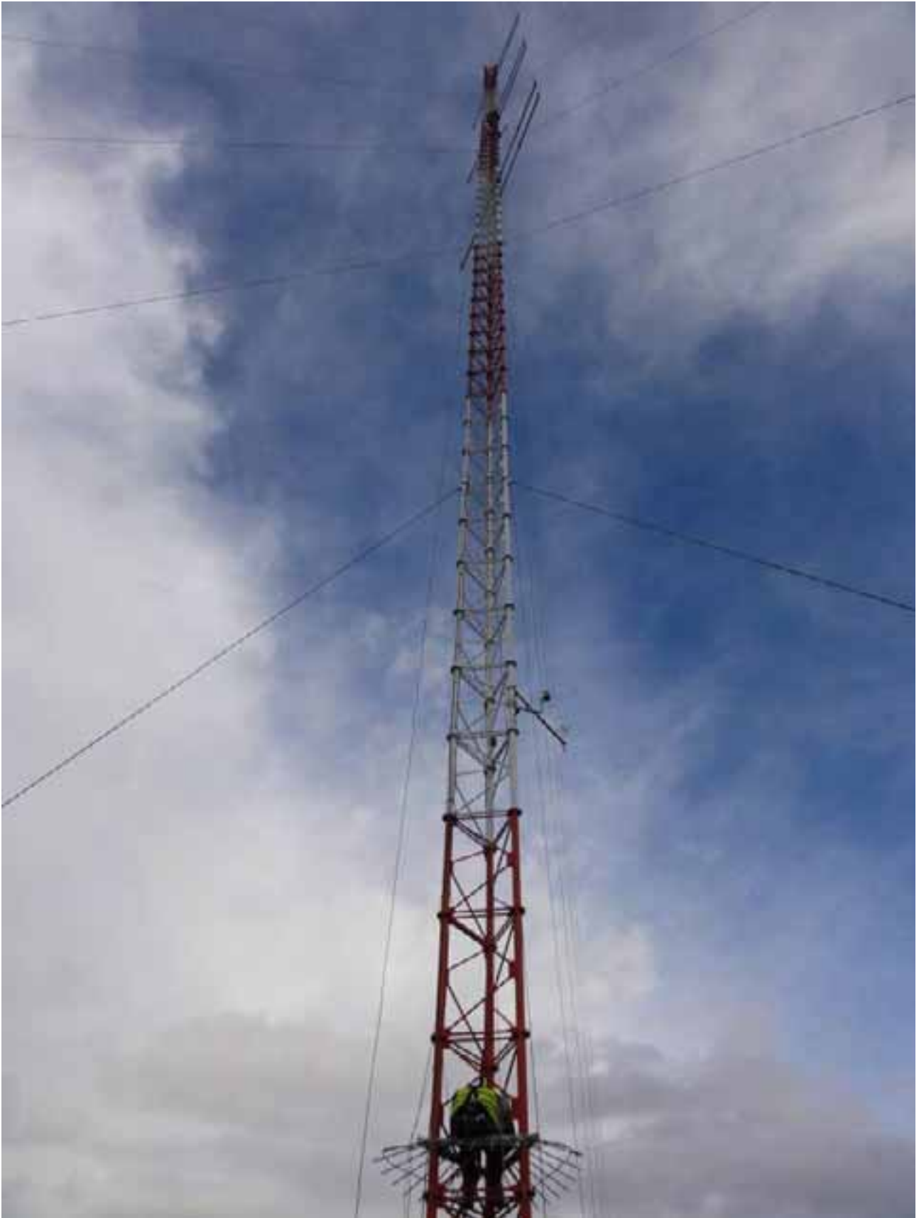
Kuva 20-1. Korkeat rakennelmat, esimerkiksi tuulimittausmastot ja tuulivoimalat tulee merkitä lentoestevaloin.
