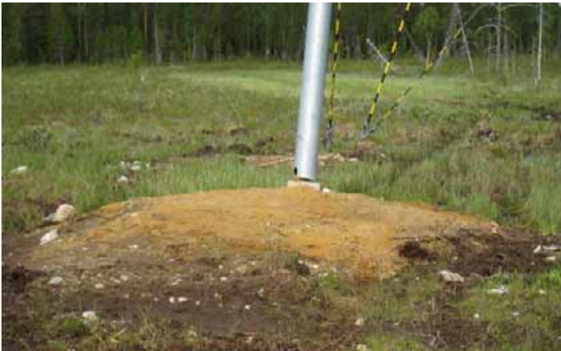
Kuva 12-3. Voimajohtopylvään perusta Riesiojan alueella.
